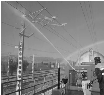
图 1 人工冲洗接触网绝缘子
